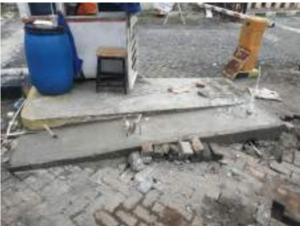
Progres pembuatan level mesin manless pintu masuk selatan untuk motor
