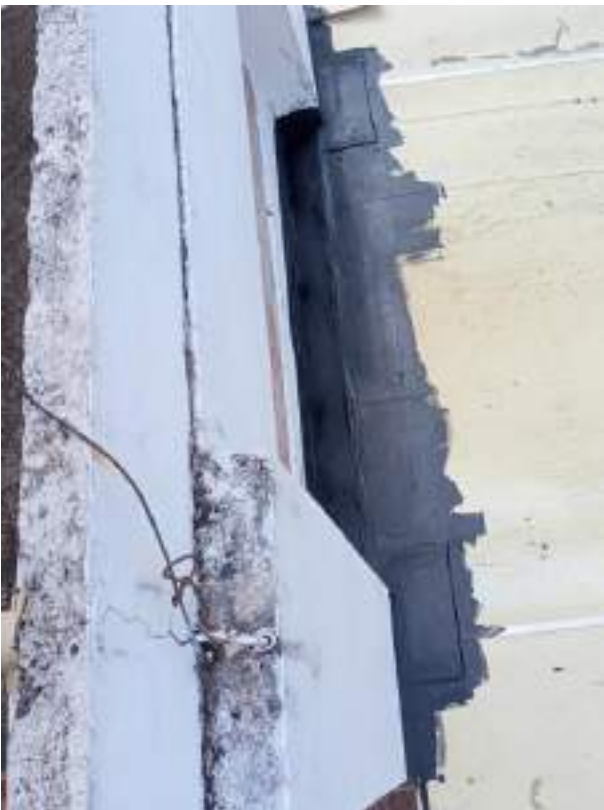
Perbaiki rembesan dengan menggunakan no drop + kasa no drop pada atap kanopi
