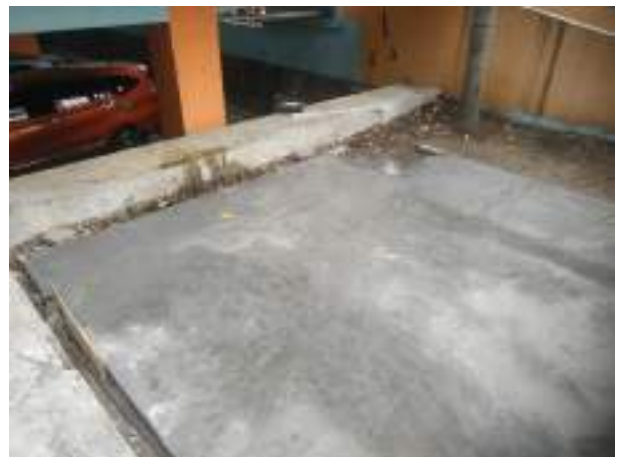
Proses pekerjaan plesteran merubah taman menjadi perluasan parkir motor
