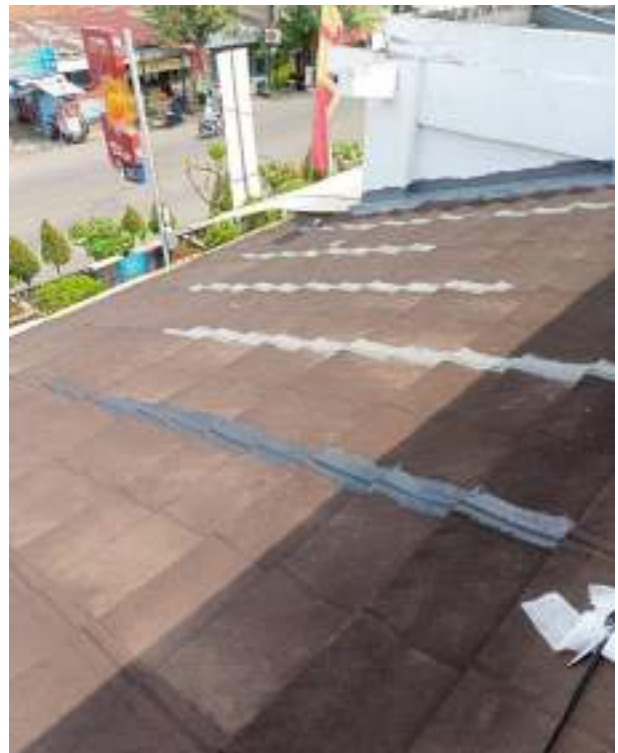
Perbaikan kebocoran dengan menggunakan no drop + kasa no drop pada atap
