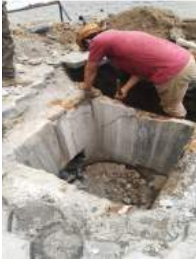
Perbaiki Sumur Resapan Pojokan Superindo
