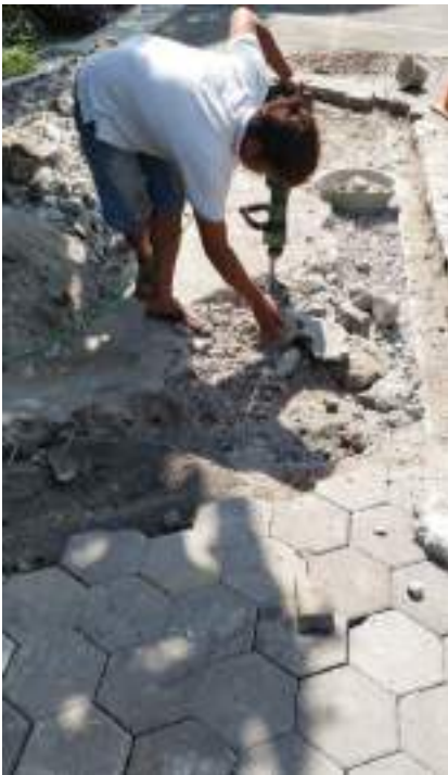
Proses perapian dengan pemasangan paving block dan pengecoran ulang di beberapa titik
