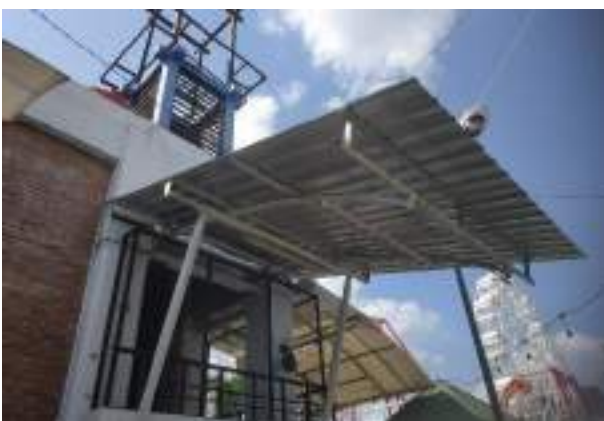
Kanopi Gedung C1 setelah dilakukan perbaikan menambah rangka dan mengganti atap galvalum
