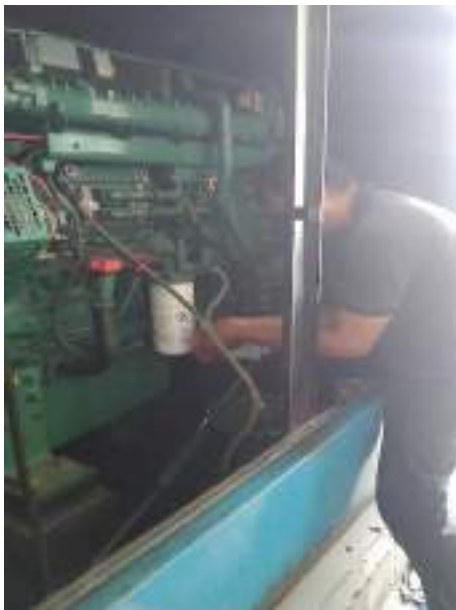
Proses penggantian filter oli dan filter solar
