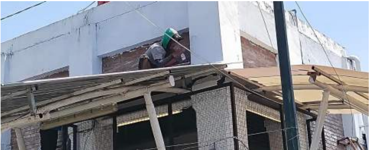
Proses perbaikan kanopi Gedung C1
