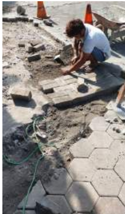
Proses perapian dengan pemasangan paving block dan pengecoran ulang di beberapa titik
