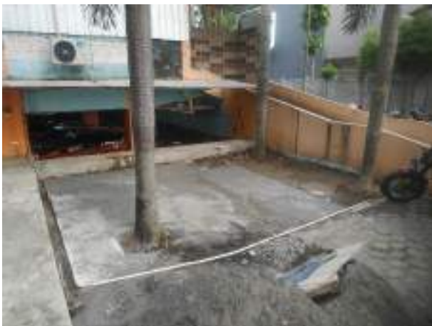
Proses pekerjaan plesteran merubah taman menjadi perluasan parkir motor
