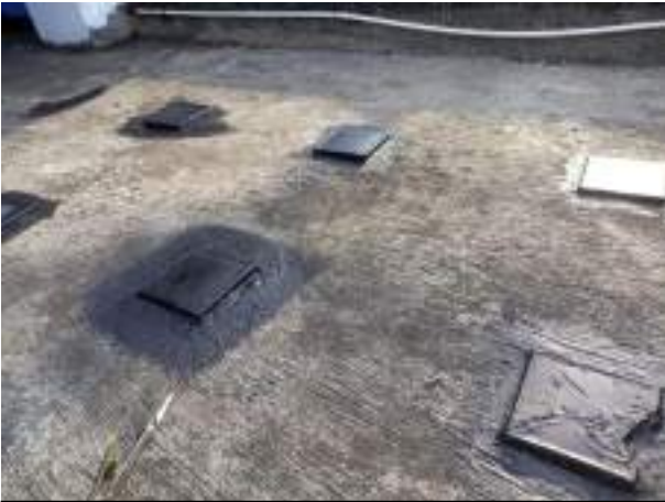
Perbaiki kebocoran dengan menggunakan no drop + kasa no drop di skylight pada atap dak
