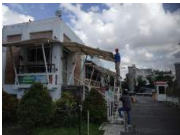
Proses perbaikan kanopi Gedung C1
