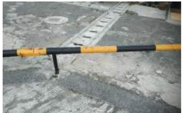
Kerusakan gutter, ramp, dan batu keping di akses jalan dari Plaza XT ke Mushola
