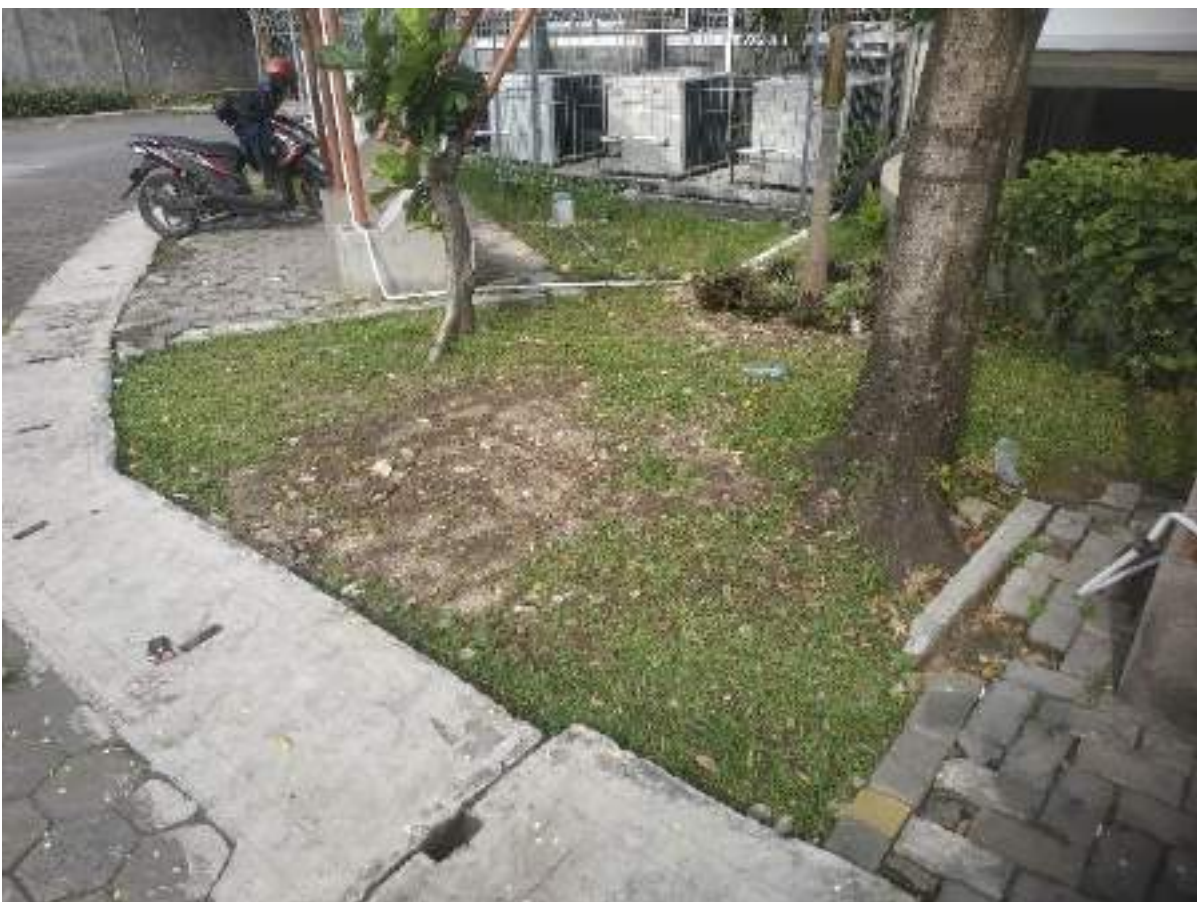
Kondisi parkir motor sebelah timur sebelum diplester untuk perluasan area
