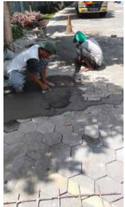
Proses perapian dengan pemasangan paving block dan pengecoran ulang di beberapa titik
