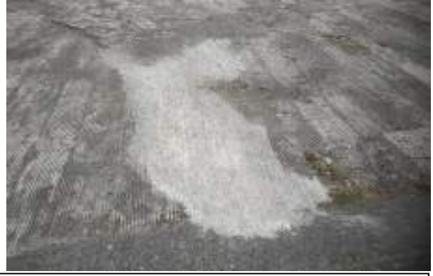
Kondisi plesteran Plaza XT setelah dilakukan perbaikan
