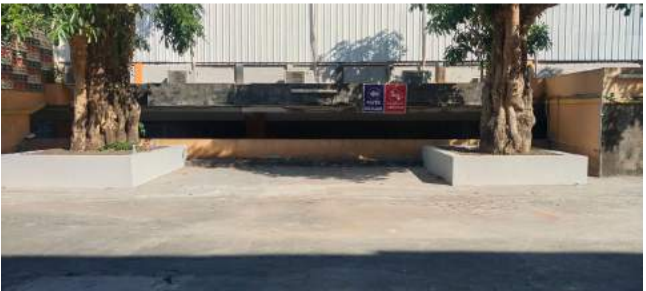
Area sebelah selatan Plaza Umar Kayam (XT Billiard) sudah dapat digunakan untuk parkir
