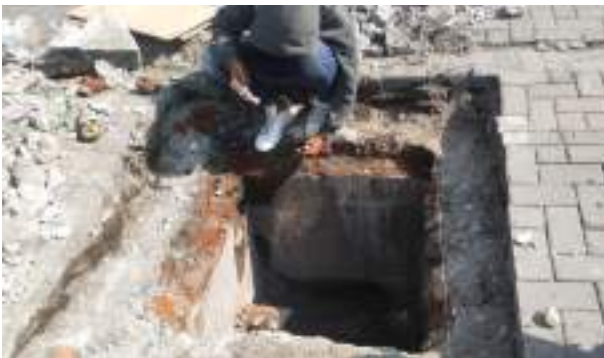
Penutup saluran yang perlu diperbaiki
