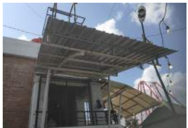
Kanopi Gedung C1 setelah dilakukan perbaikan menambah rangka dan mengganti atap galvalum
