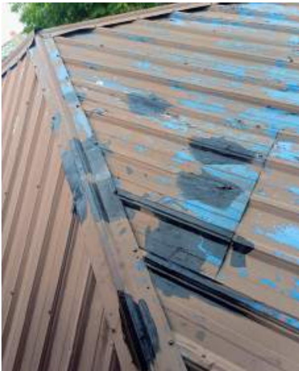
Perbaikan kebocoran dengan menggunakan no drop + kasa no drop pada atap
