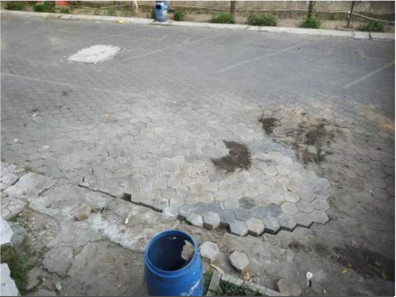
Kondisi paving blok timur Plaza Umar Kayam setelah dilakukan diperbaiki
