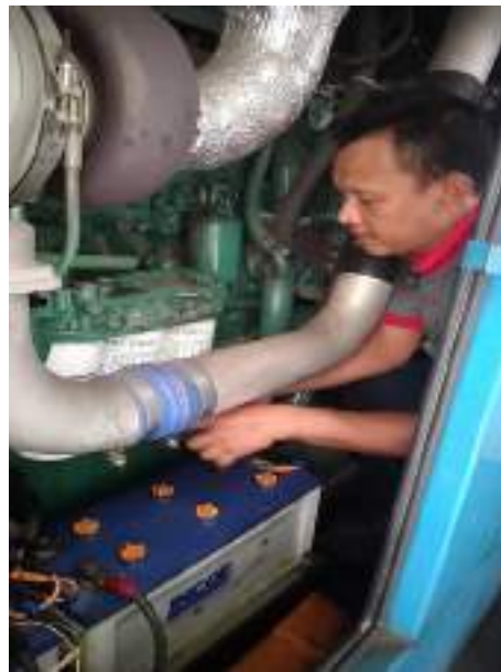
Proses penggantian filter oli dan filter solar
