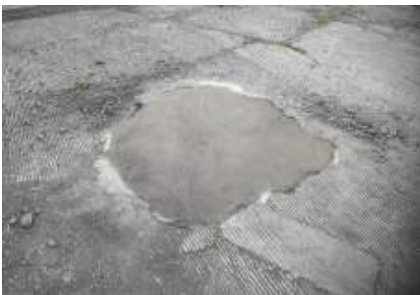
Kondisi plesteran Plaza XT setelah dilakukan perbaikan
