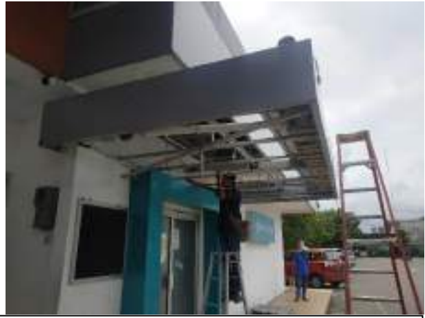
Proses perbaikan kerusakan atap dan plafon Selasar Kantor Kas Bank Jogja
