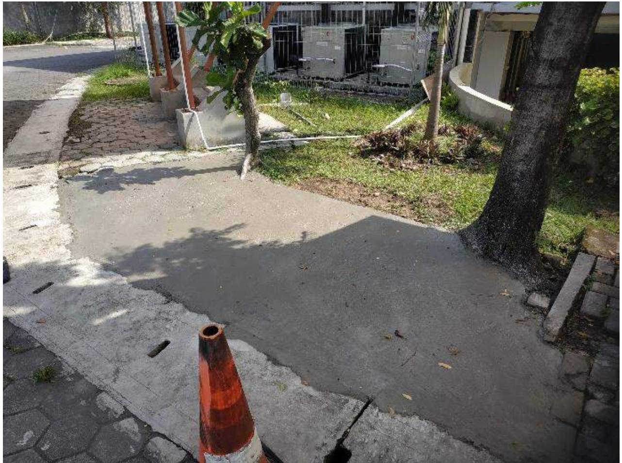
Kondisi parkir motor sebelah timur setelah diplester untuk perluasan area
