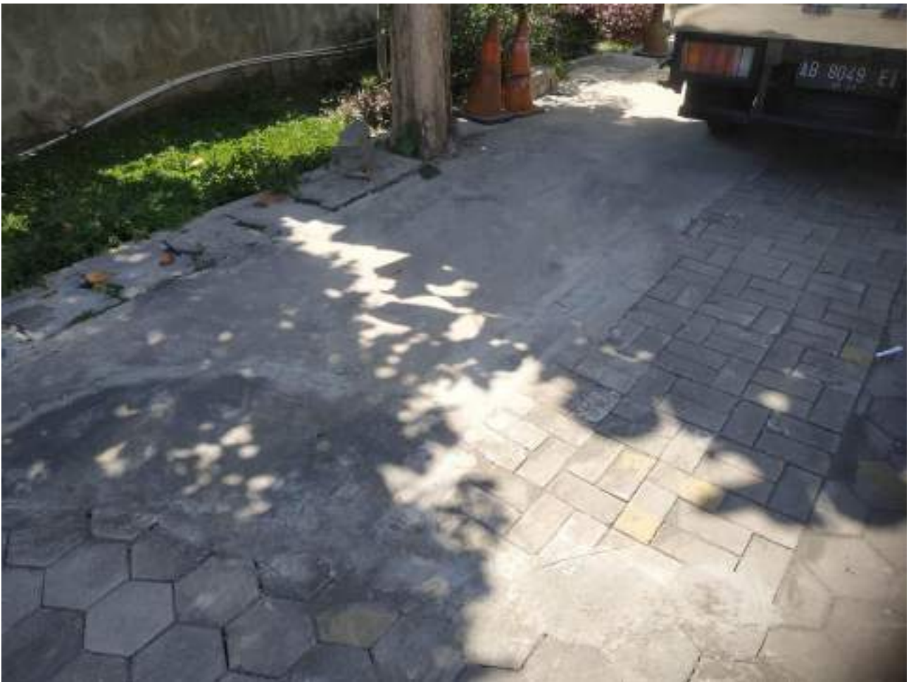
Kondisi jalan setelah selesai dilakukan perapian
