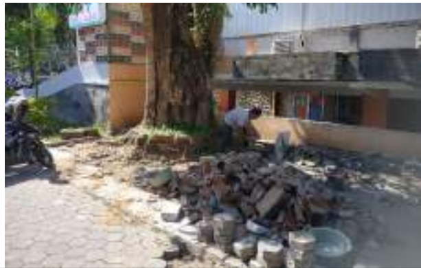
Proses pembongkaran paving block dan pot pohon pule yang lama
