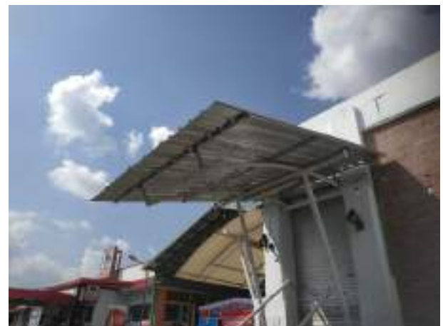
Kanopi Gedung C1 setelah dilakukan perbaikan menambah rangka dan mengganti atap galvalum
