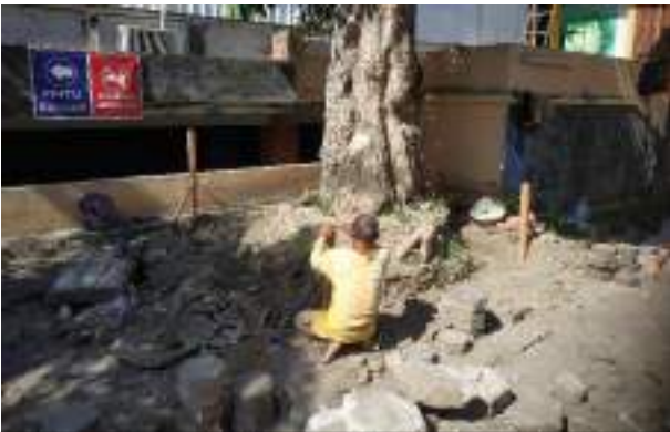
Proses pembongkaran paving block dan pot pohon pule yang lama
