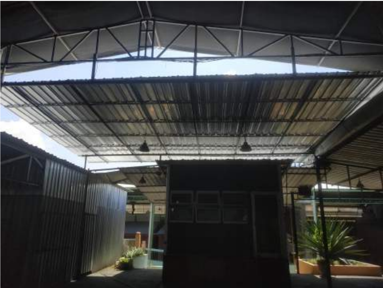
Kondisi atap Plaza Umar Kayam sesudah dilakukan perbaikan dan diganti dengan galvalum
