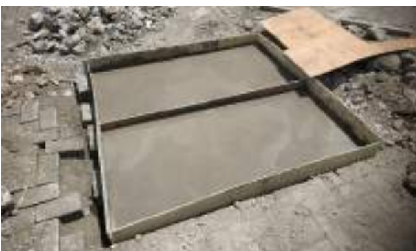
Proses pembongkaran, pemasangan bekisting dan pengecoran penutup saluran sampai dengan selesai
