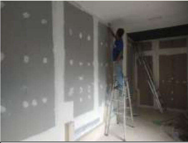
Proses pemasangan pendempulan, pengecatan dan pemasangan pintu ruangan
