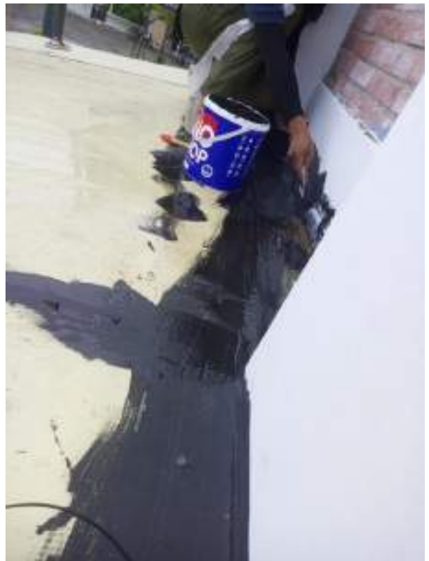
Perbaiki rembesan dengan menggunakan no drop + kasa no drop pada atap kanopi
