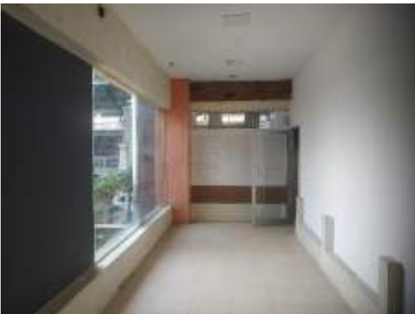
Kondisi ruangan setelah dilakukan penyekatan partisi dan pemasangan pintu
