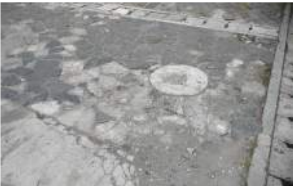
Kerusakan gutter, ramp, dan batu keping di akses jalan dari Plaza XT ke Mushola
