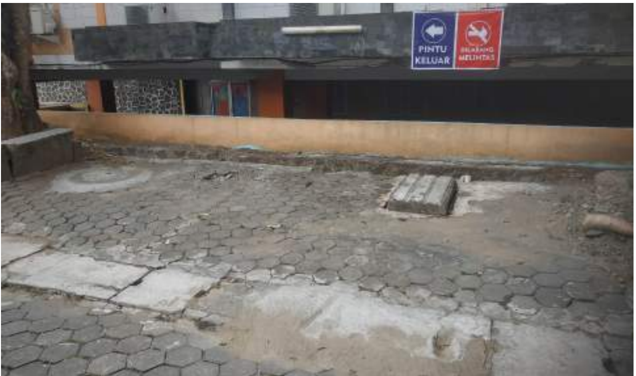
Kondisi area sebelah selatan Plaza Umar Kayam yang akan dilakukan perapian dengan cara dicor dan dibuatkan pot baru untuk pohon pule sehingga nantinya dapat digunakan untuk parkir motor
