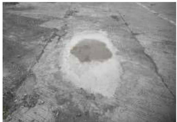
Kondisi plesteran Plaza XT setelah dilakukan perbaikan
