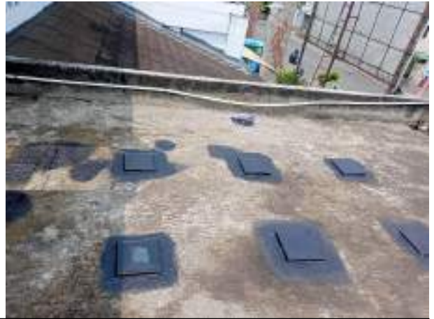
Perbaiki kebocoran dengan menggunakan no drop + kasa no drop di skylight pada atap dak
