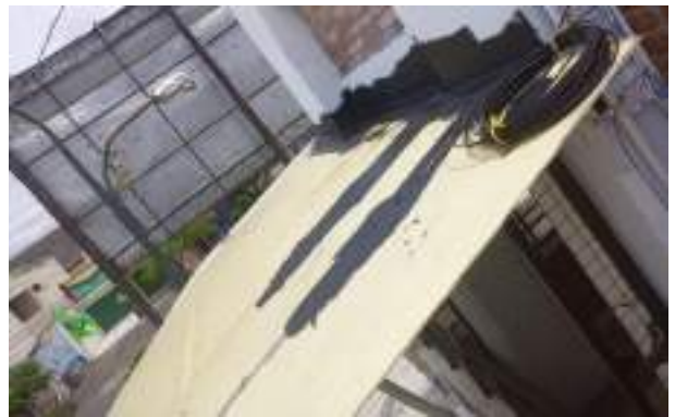
Perbaiki kebocoran dengan menggunakan no drop + kasa no drop di skylight pada atap dak
