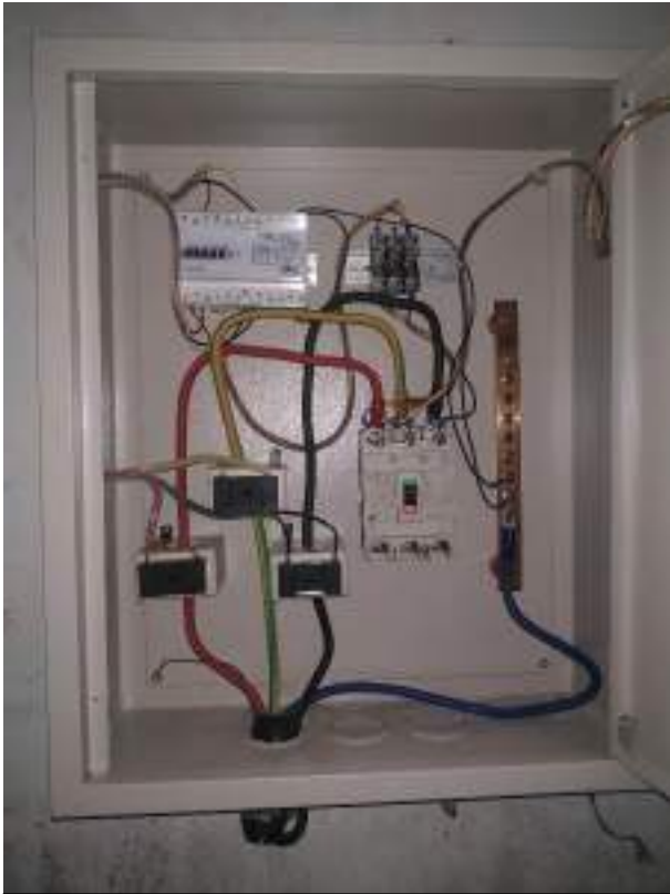
Kwh meter 3 phase sudah terpasang
