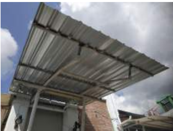
Kanopi Gedung C1 setelah dilakukan perbaikan menambah rangka dan mengganti atap galvalum
