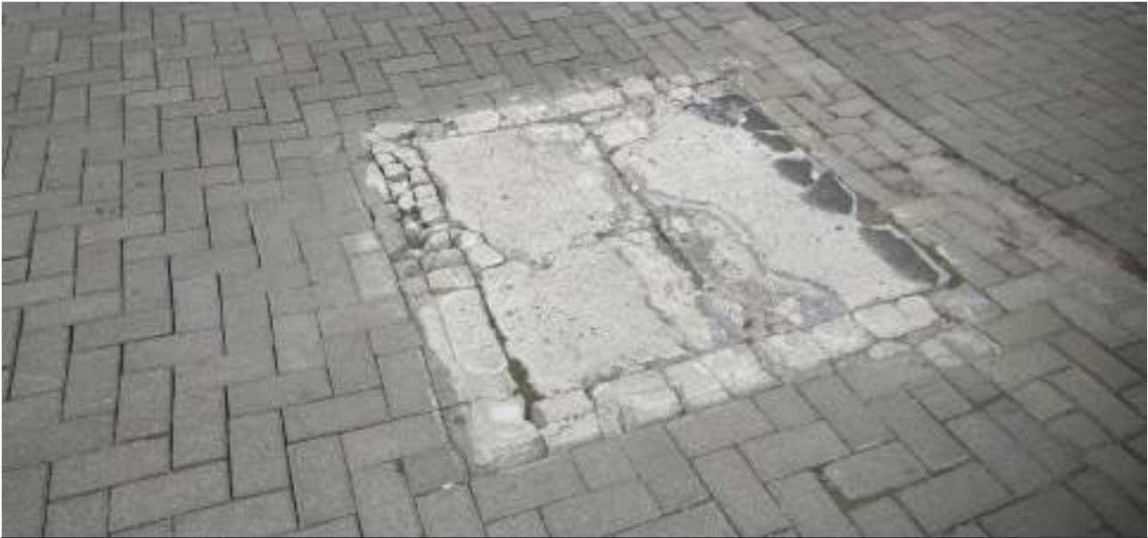
Penutup saluran yang perlu diperbaiki
