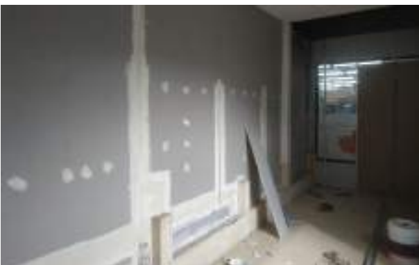
Proses pemasangan partisi dan pembongkaran untuk akses keluar masuk ruangan
