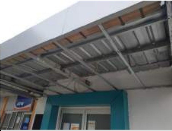
Proses perbaikan kerusakan atap dan plafon Selasar Kantor Kas Bank Jogja
