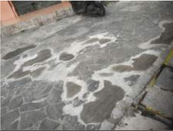
Perbaiki batu keping jalan untuk akses jalan dari Plaza XT ke Mushola
