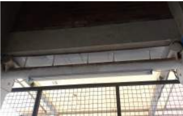
Perbaiki kebocoran dengan menggunakan no drop + kasa no drop di skylight pada atap dak
