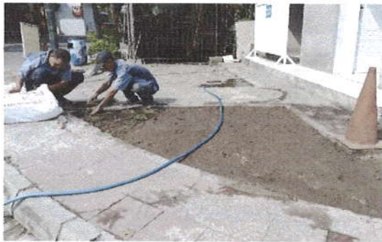
Progres Taman Depan Toilet
