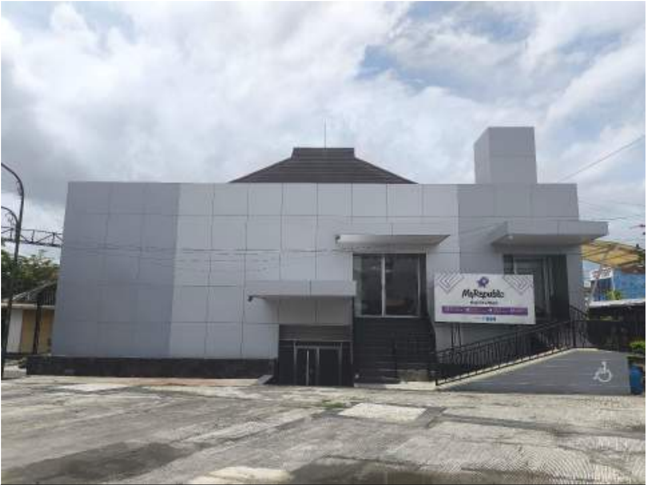
Fasade alumunium composite panel sudah selesai terpasang
