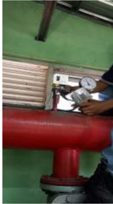
Ganti Oli Diesel Hydrant dan Penggantian pressure switch main pump hydrant & Pressure Switch Jockey Pump( yang lama sudah rusak)
