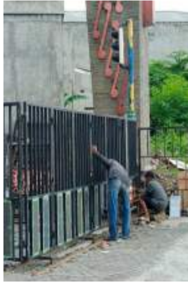
Progres Pemasangan Pagar Lipat Pintu Keluar Selatan
