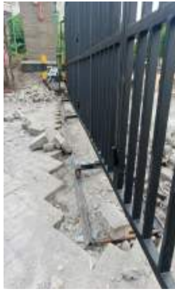
Pemasangan Rel Roda Pagar Lipat
