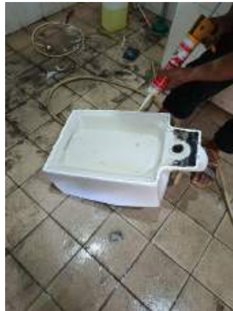
Perbaikan Drainase Urinoir Toilet Cowok Gd.C1
