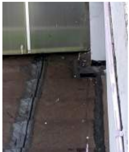
Perbaikan kebocoran dengan menggunakan no drop + kasa no drop pada atap Gedung C1
