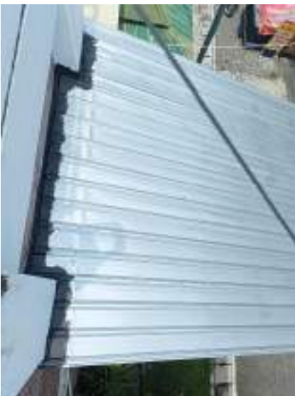
Perbaikan kebocoran dengan menggunakan no drop + kasa no drop pada atap kanopi Gedung C1 dan pada atap tambahan antara Gedung C1 dan XT Lane
