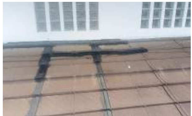
Perbaikan kebocoran dengan menggunakan no drop + kasa pada bagian atap Gedung C1
