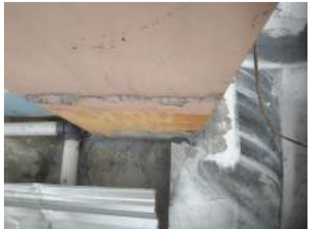
Perbaikan kebocoran dengan menggunakan no drop + kasa no drop pada bagian topi-topi dak
