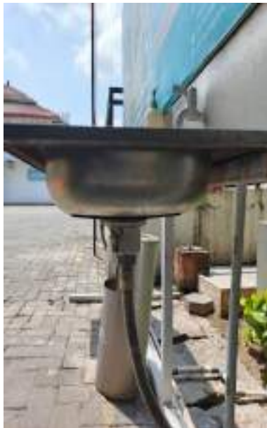
Penggantian Afur Wastafel Depan Gapura XT Lane, sebelumnya memakai afur plastic diganti dengan afur berbahan alumunium
