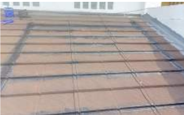
Perbaikan kebocoran dengan menggunakan no drop + kasa pada bagian atap Gedung C1
