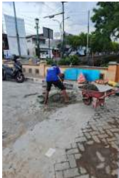
Progres Pengecoran Rel Pagar Lipat Pintu Selatan
