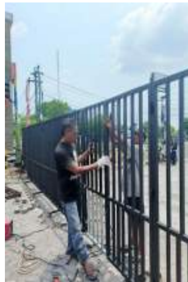
Pemasangan Rel Roda Pagar Lipat
