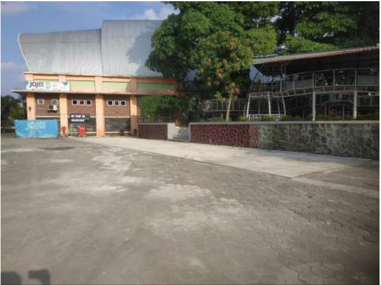
Pekerjaan perbaikan jalan dan parkir sisi selatan telah selesai dilakukan
