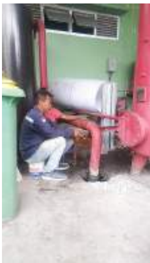
Perbaikan Instalasi Hydrant
