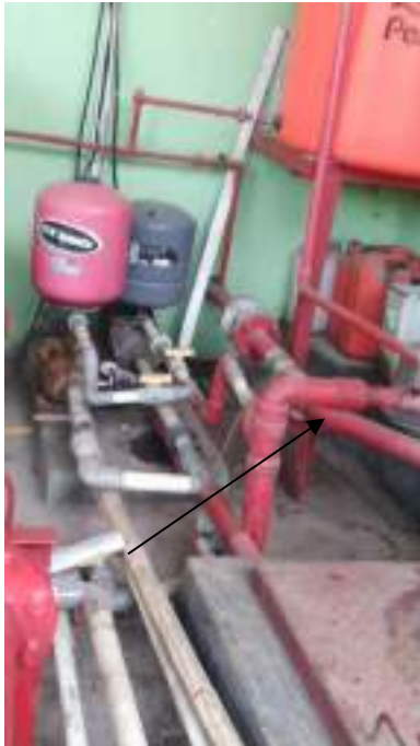
Pembuatan jalur pipa jockey pump yang baru
