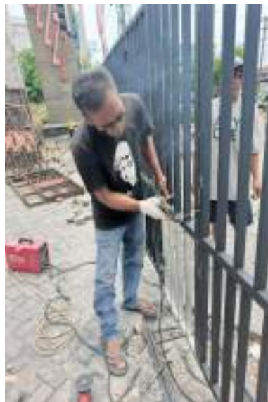
Pemasangan Rel Roda Pagar Lipat
