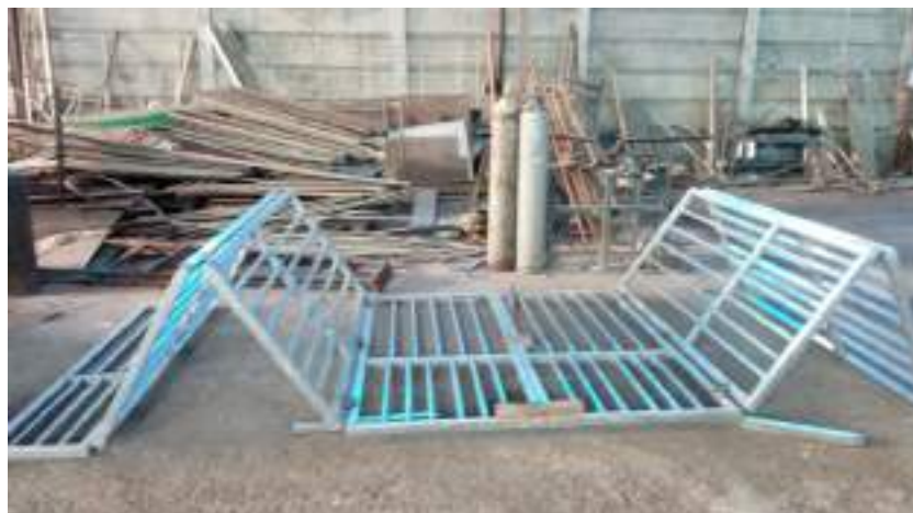
Progres Pembuatan Pagar Lipat Pintu Selatan ( Proses Pengelasan)
