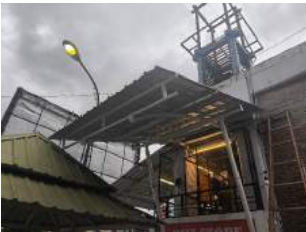
Kanopi setelah dilakukan perbaikan dengan mengganti atap kanopi polikarbonat ke galvalum
