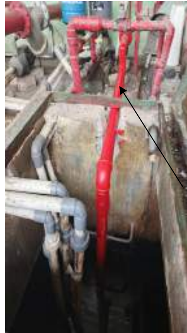
Pembuatan jalur pipa jockey pump yang baru
