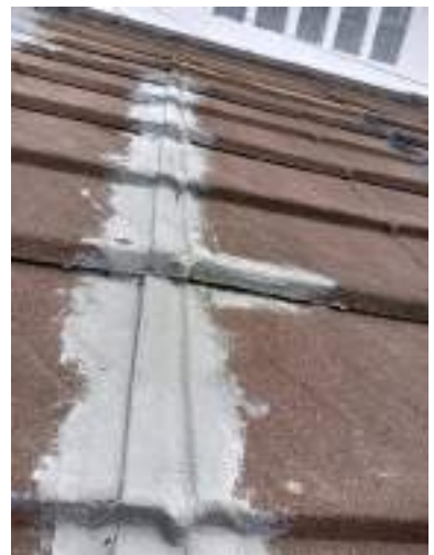
Perbaikan kebocoran dengan menggunakan no drop + kasa no drop pada atap Gedung C1
