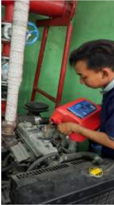
Ganti Oli Diesel Hydrant dan Penggantian pressure switch main pump hydrant & Pressure Switch Jockey Pump( yang lama sudah rusak)
