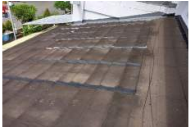
Titik kebocoran pada Gedung C1 dan masih terdapat beberapa titik berdasarkan laporan tenant
