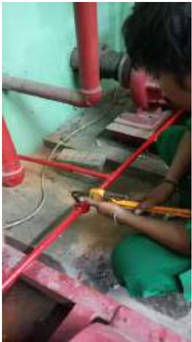
Pembuatan Pembuangan Air Dari Sambungan Puley Motor ke Pompa
