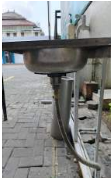
Penggantian Afur Wastafel Depan Gapura XT Lane, sebelumnya memakai afur plastic diganti dengan afur berbahan alumunium
