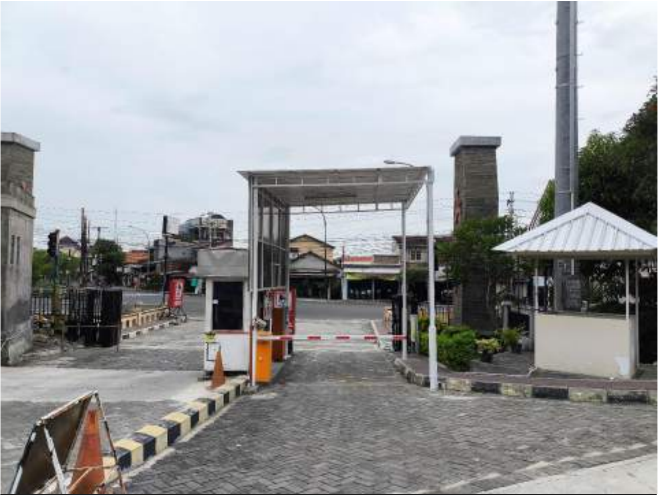
Pintu masuk selatan sudah selesai dikerjakan dan sudah dapat dilewati mobil
