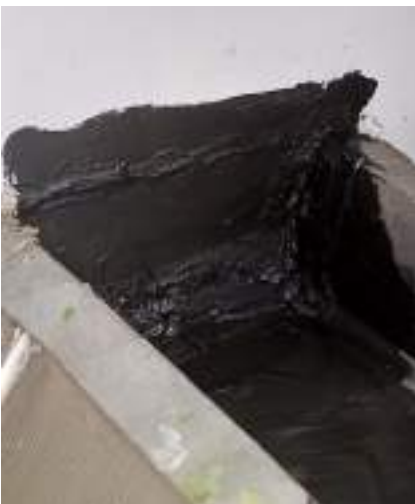
Perbaikan kebocoran dengan menggunakan no drop + kasa no drop pada atap Gedung C1
