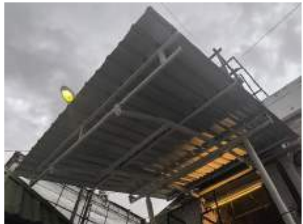
Kanopi setelah dilakukan perbaikan dengan mengganti atap kanopi polikarbonat ke galvalum
