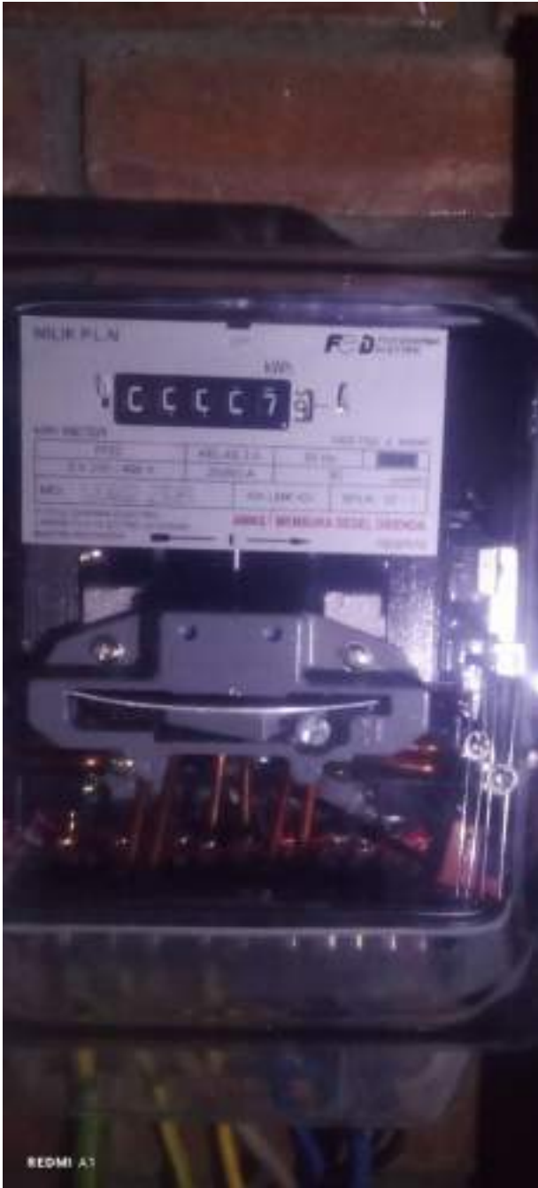
Meteran setelah diganti 7.9
