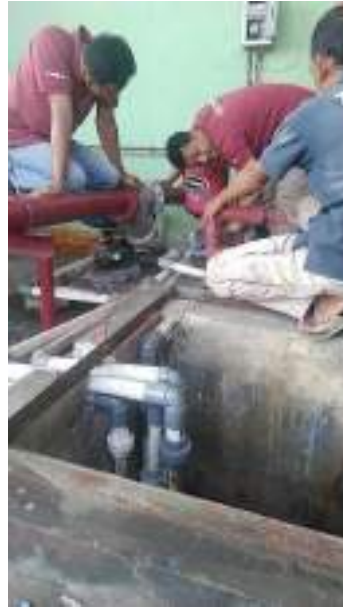
Penggantian foot klep dan pemasangan pompa
