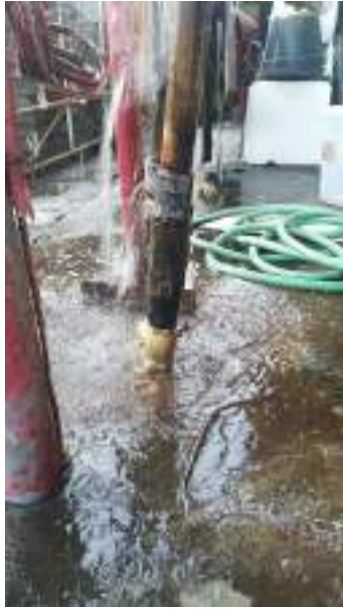
Penggantian foot klep dan pemasangan pompa
