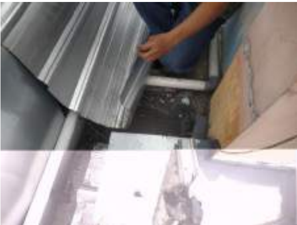
Perbaikan kebocoran dengan menggunakan no drop + kasa no drop pada bagian topi-topi dak
