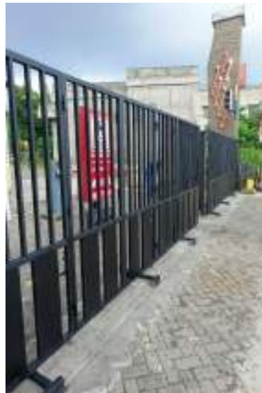
Progres Amplas dan Finishing Cat Pagar Lipat Pintu Selatan
