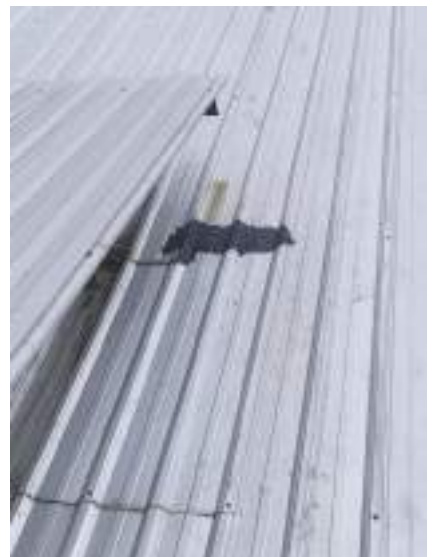
Perbaikan kebocoran dengan menggunakan no drop + kasa no drop pada atap kanopi Gedung C1 dan pada atap tambahan antara Gedung C1 dan XT Lane
